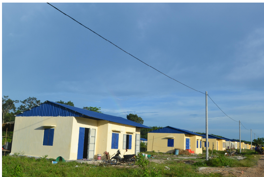
Hình 13 - Nhà ở công nhân và đường điện do Công ty CP Cao su Bà Rịa Kampong Thom xây dựng
